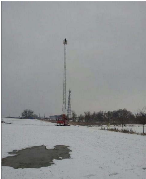
(a) Positionierung der Drehleiter
